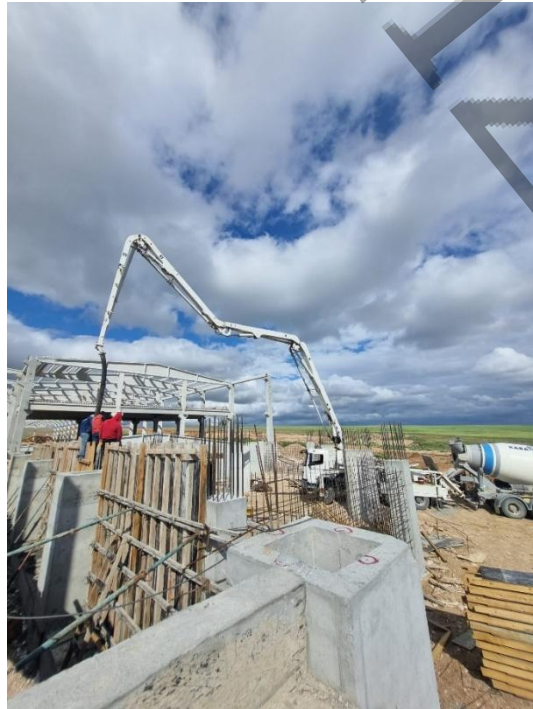
Resim-8 İdari Bina Perde Beton Dökümü
