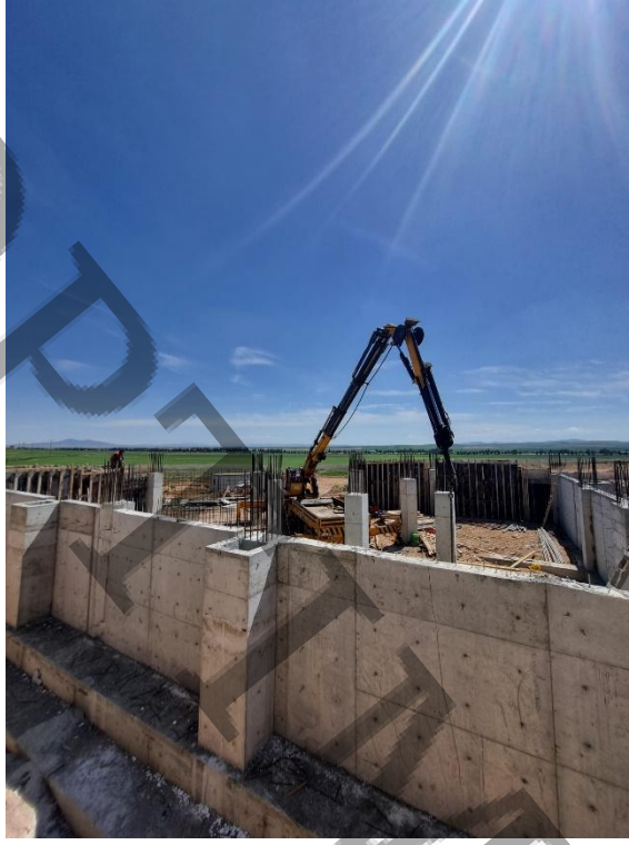
Resim-8 İdari Bina Perde Beton Dökümü
