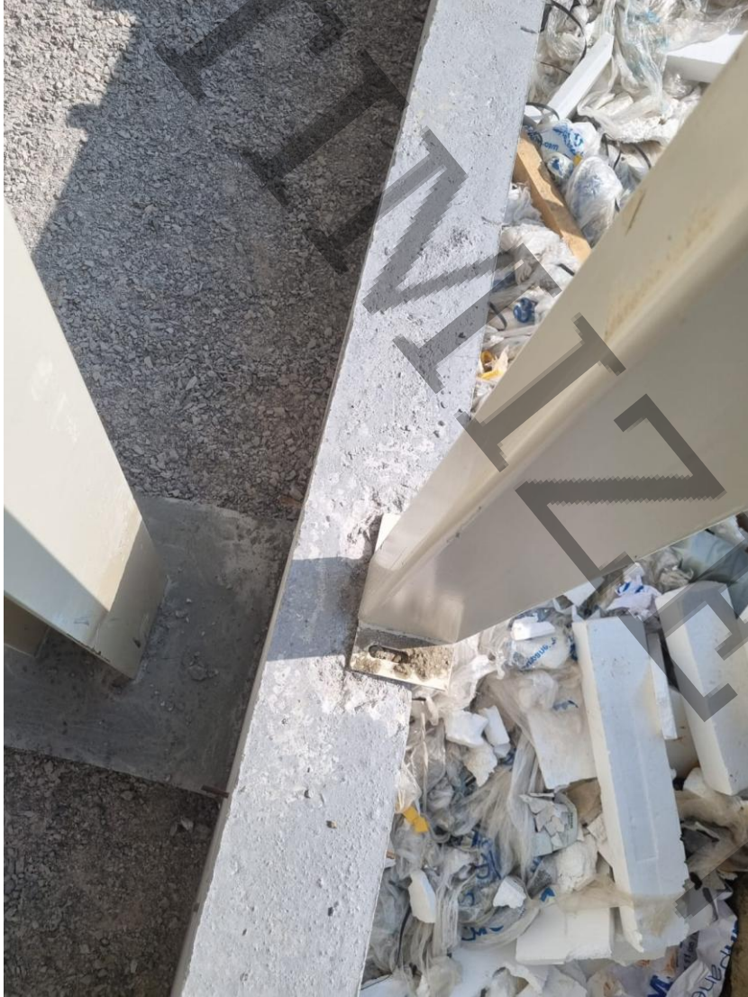
Resim-4 Çelik Montajı Kaynaklı Betonarme Hasarı
