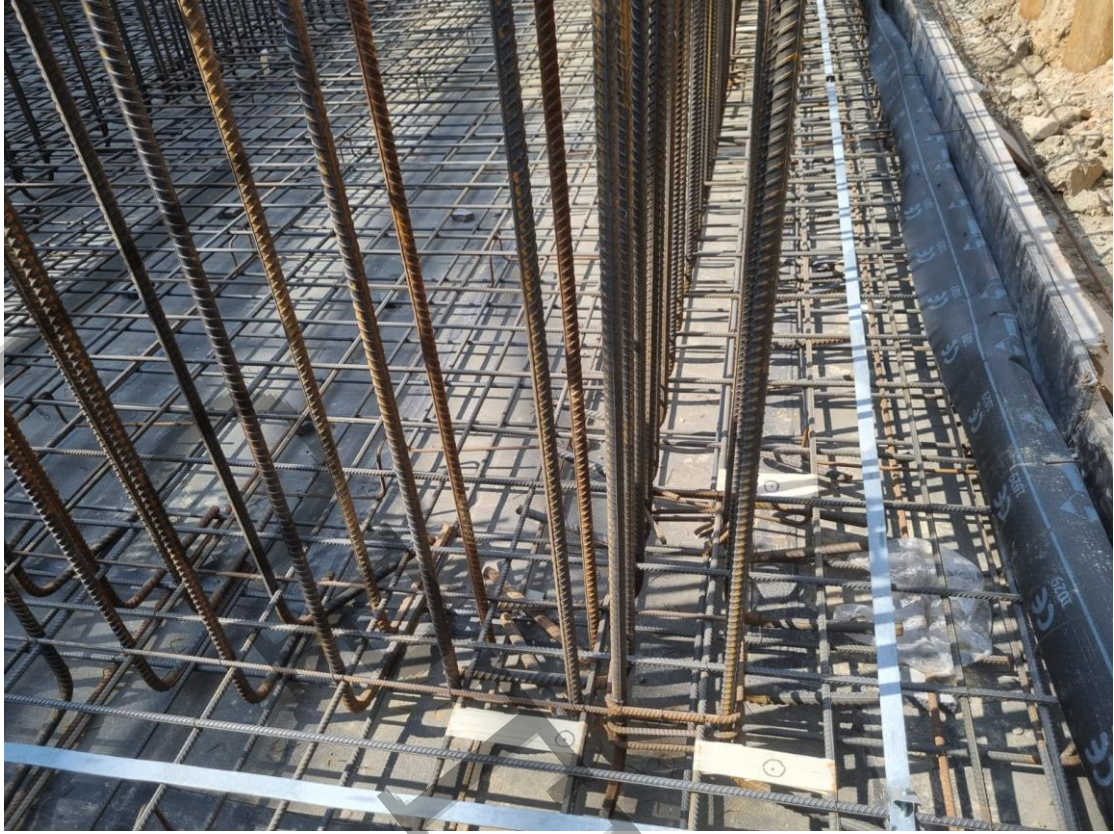
Resim-8 Betonarme Yapı Dışında Kalan Demirler
