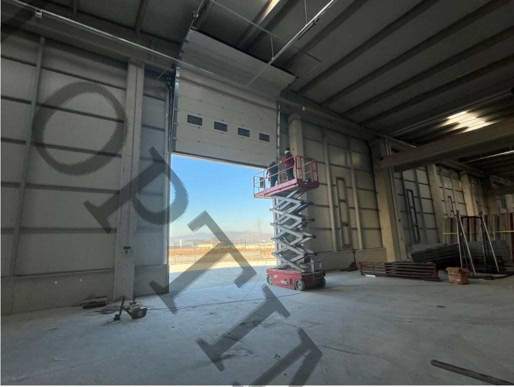
Resim-15 Tava Konsol İmalatı ve Montajı
