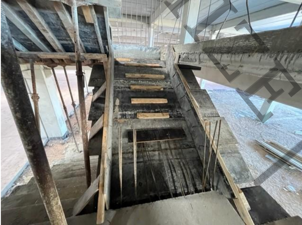
Resim-4 Betonarme Yangın Merdiveni
