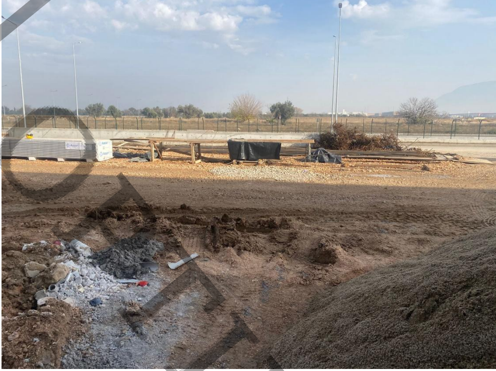
Resim-13 Konteynır Altı Beton Dökümü
