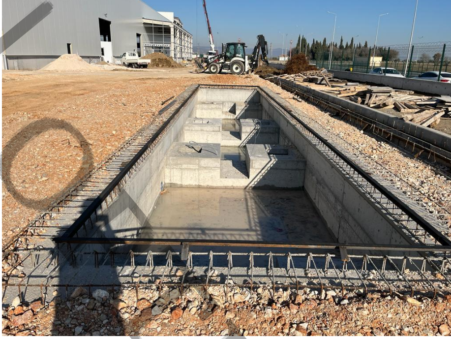
Resim-10 Kantar Drenaj Hattı
