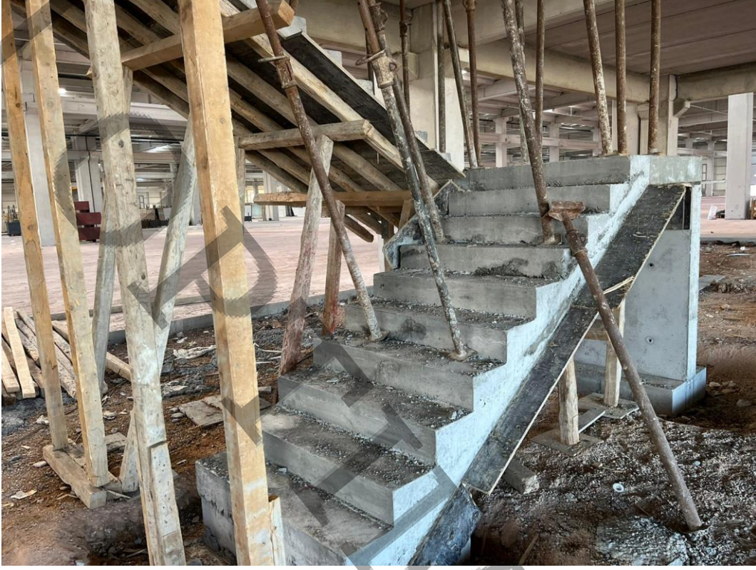
Resim-4 Betonarme Yangın Merdiveni
